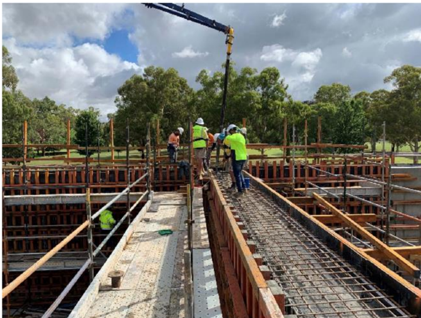
Photo 2: Concrete pour for balance tank.
